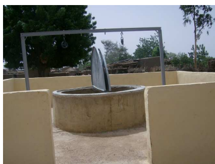
Puits à grand diamètre dans le village de N'Golokuna
