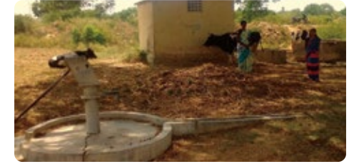
故障したものの修理されていない 手押しポンプ式井戸
