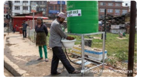
バス停にある手洗い設備を足で操作して手を洗う通行人(ネパール、ラリトプール)
