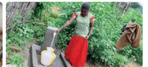
完成した給水設備
