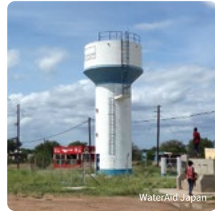
電気が止められ、機能していない給水タワー(モザンビーク)
