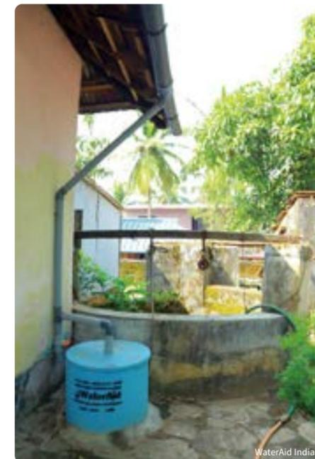
屋根から集められた雨水を、フィルターで洗浄・ろ過した後、手掘り井戸に流す設備。設置後は、夏の間も井戸が枯れなくなり、水質も改善したとの声が寄せられている
