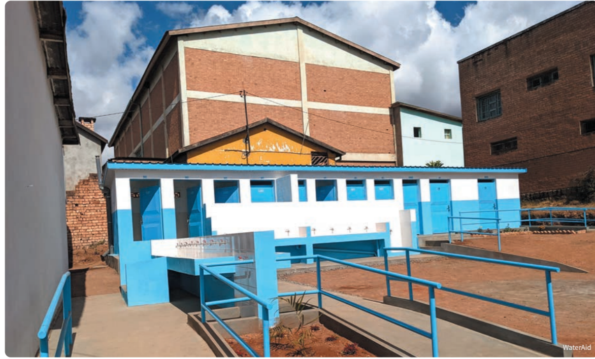
学校に設置したトイレ棟と手洗い設備(マダガスカル)
