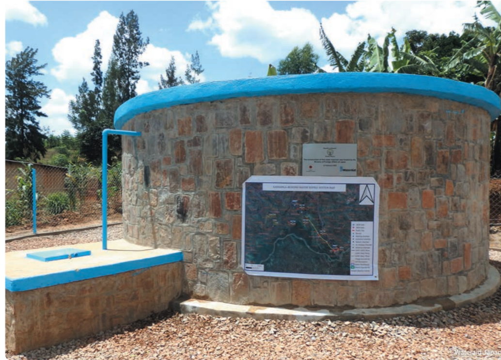
完成した貯水槽
